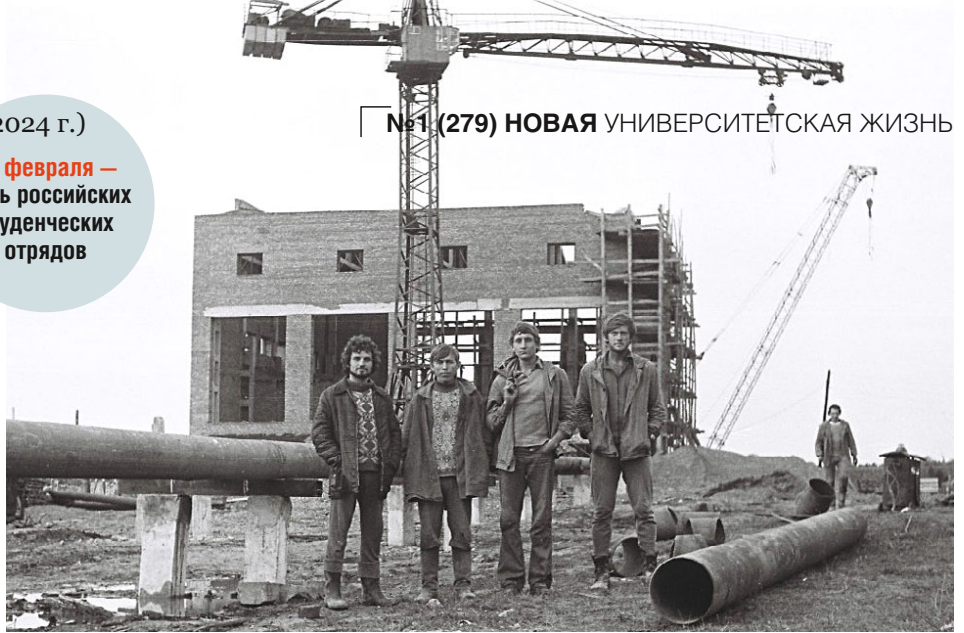
ССО «Атлант», 1972 г. Монтаж стальных каркасов котельной курорта «Озеро Учум»
